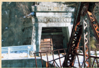
16 小滝の坑口 (市指定史跡)
