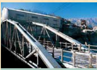
7 古河橋 (国重要文化財)
